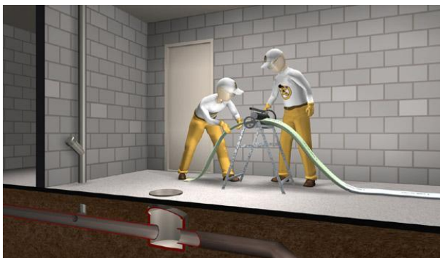
Zdjęcie 2: Kalibracja za pomocą rolek kalibrujących.
