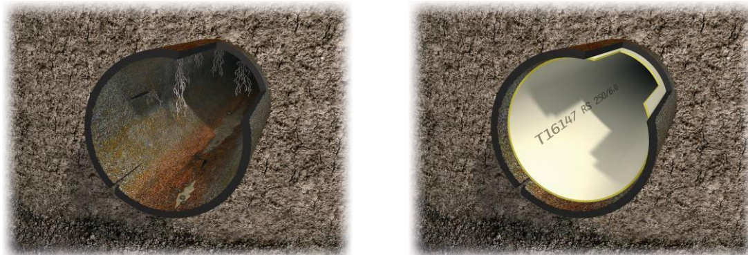
Zdjęcie 1: Kanał ściekowy przed i po renowacji.
